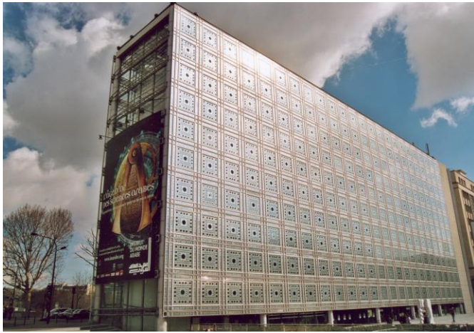
Fig. 6. Institut du Monde Arabe in Paris Mechanical Façade [33]
